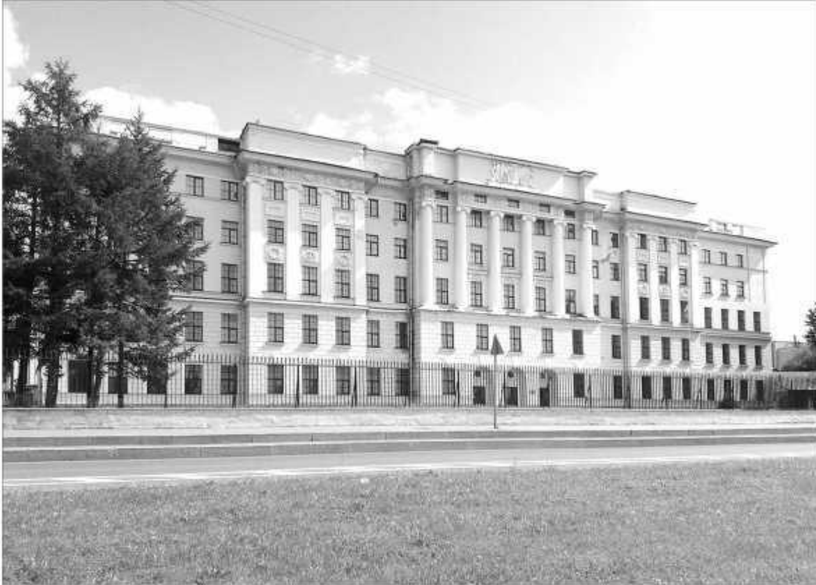
Вид на здание Главного гидрографического управления со стороны набережной. Фото Н. Столбовой. 2019 г.
