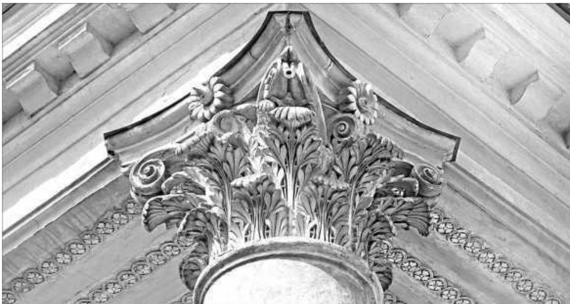
Дача Безобразовых. Капитель колонны южного портика. Фото О. Еверзова. 2017 г.
