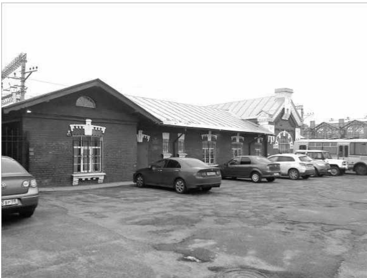
Здание железнодорожной станции «Дача Долгорукова». Северо-западный фасад. Фото Н. Столбовой. 2019 г.
