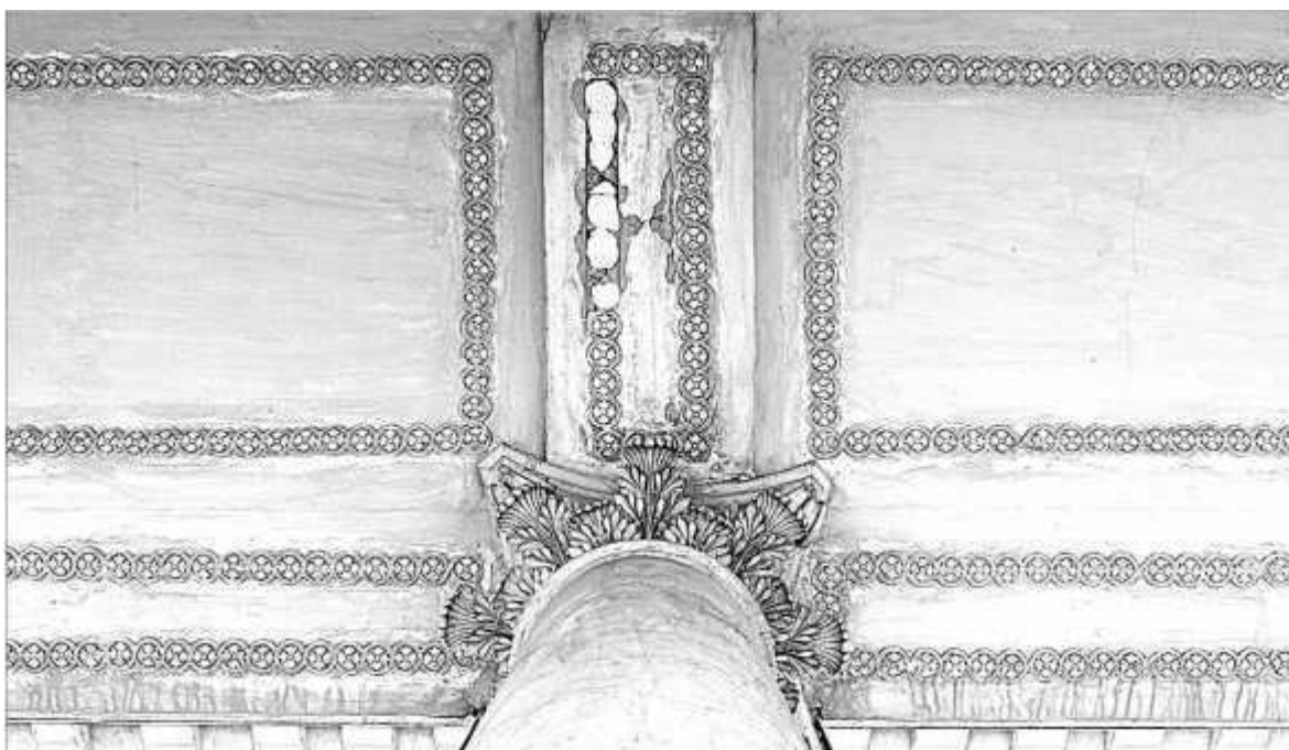
Дача Безобразовых. Вид на плафон южного портика. Фото О. Еверзова. 2017 г.
