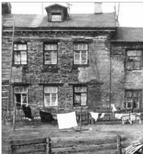
Дача Безобразовых. Южный фасад. Западная часть. Фототека КГИОП. 1966 г.
