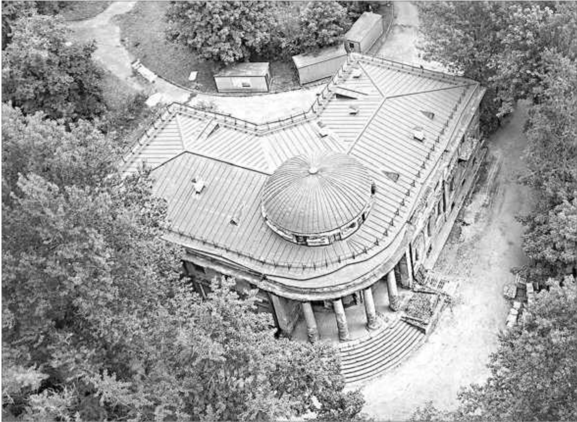
Уткина дача. Главный корпус. Фото А. Медведевой. 2019 г.
