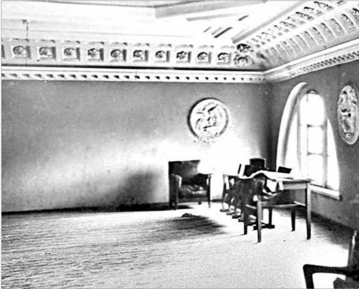
Дача Безобразовых. Междуэтажное перекрытие в главном зале. Фототека КГИОП. 1974 г.
