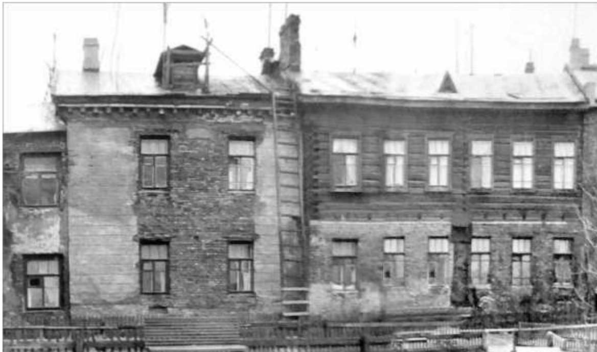
Дача Безобразовых. Северный фасад. Западная часть. Фототека КГИОП. 1966 г.
