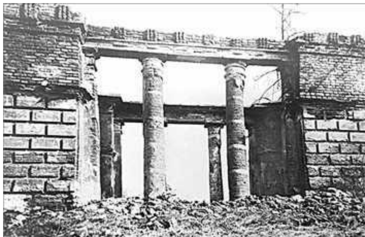
Дача Безобразовых. Пристань. Вид со стороны реки Охта. Фототека КГИОП. Нач. 1970-х гг.
