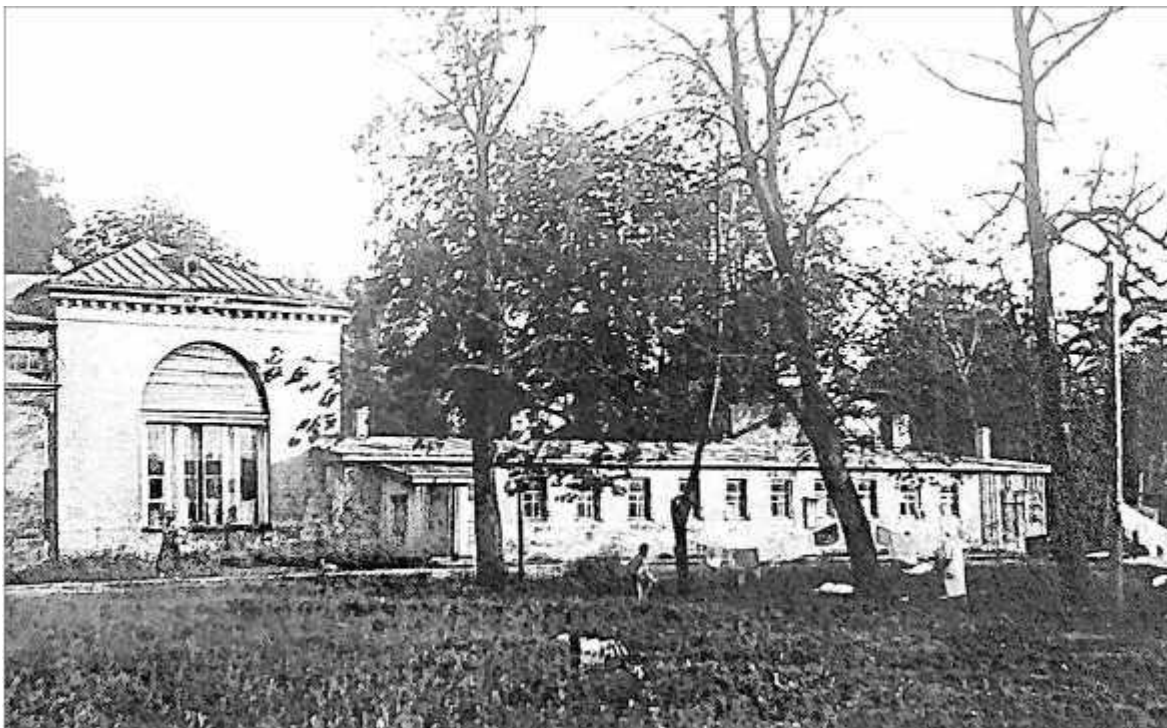
Дача Безобразовых. Северный фасад. Западная часть Фототека КГИОП. 1938 г.
