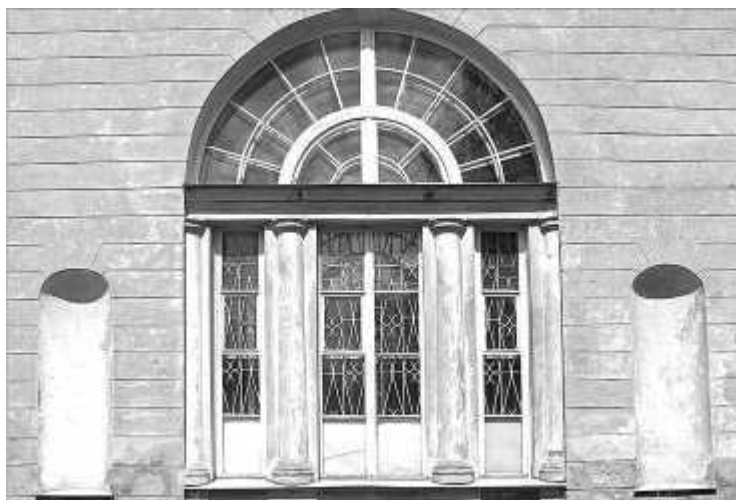
Дача Безобразовых. Южный фасад. Фрагмент. Фото О. Еверзова. 2017 г.
