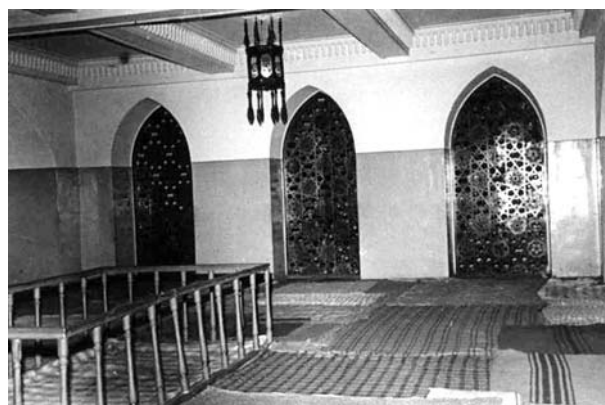
147. Помещение мечети после ремонта. 1956 г.
