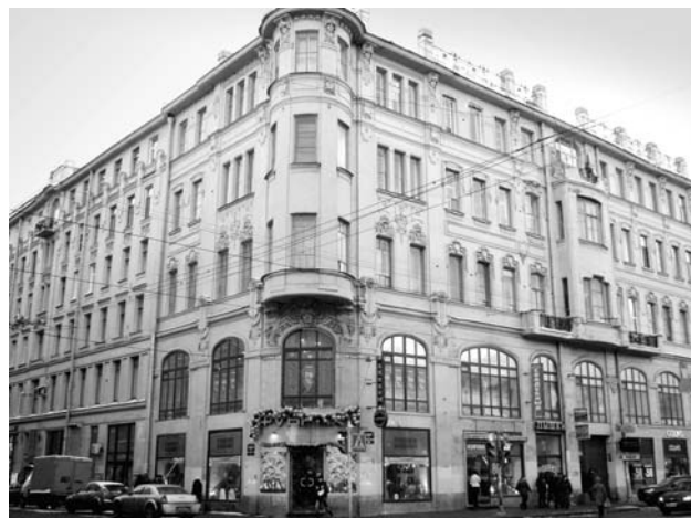
106. Здание бывшего Дома народов Востока. Садовая ул., д. 32/1. Фото автора
