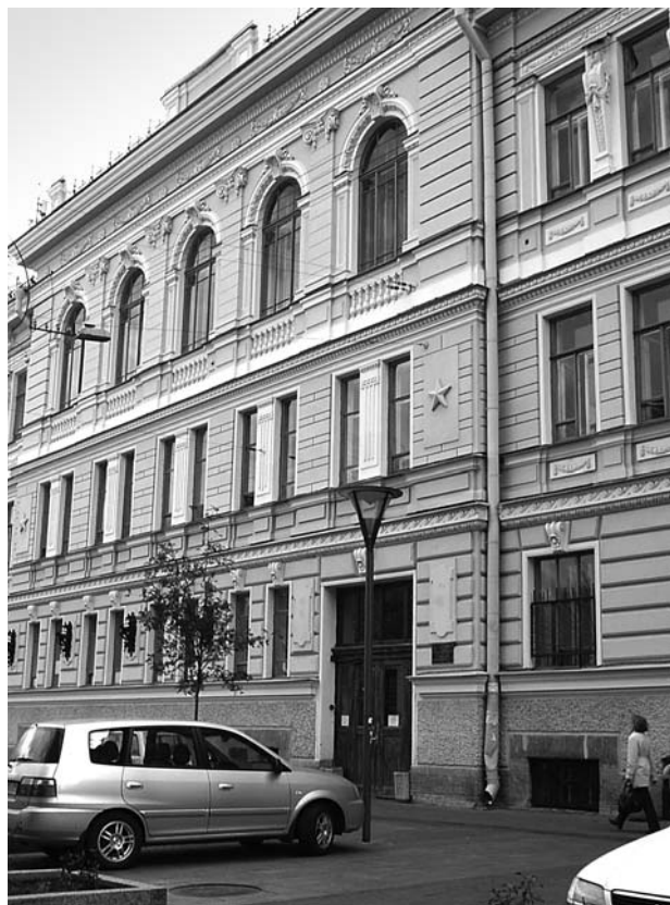
71. Ул. Правды, д. 18 (бывшее здание Губернской земельной управы). Фото автора
