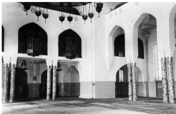
146. Основной зал мечети после ремонта. 1956 г.
