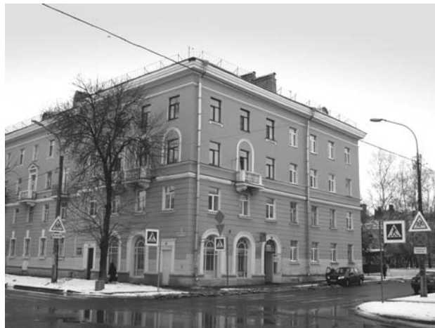
50. Кронштадт. Ленинградская ул., д. 3. Фото автора
