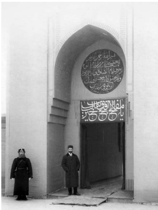
38. Временный вход в строящуюся мечеть. 1910 г.
