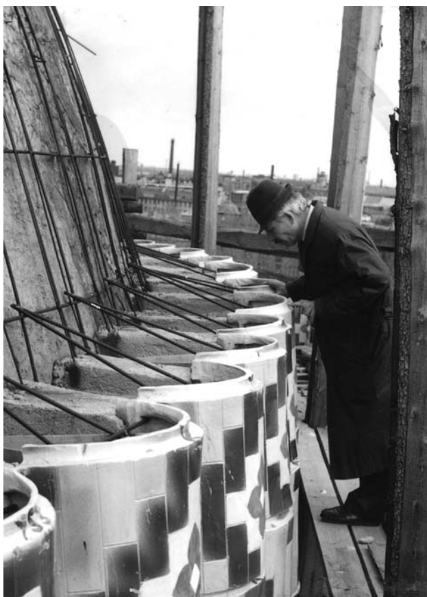
141. Ж.Н. Пончаев осматривает укладку облицовки. 1995 г. Фото М.Ф. Муратовой
